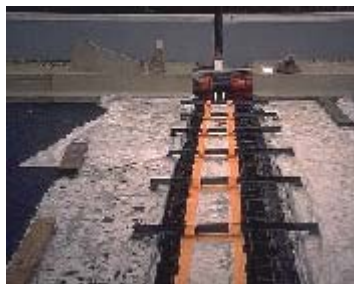
joint de chaussée avant bétonnage (photo Sétra/CTOA)
